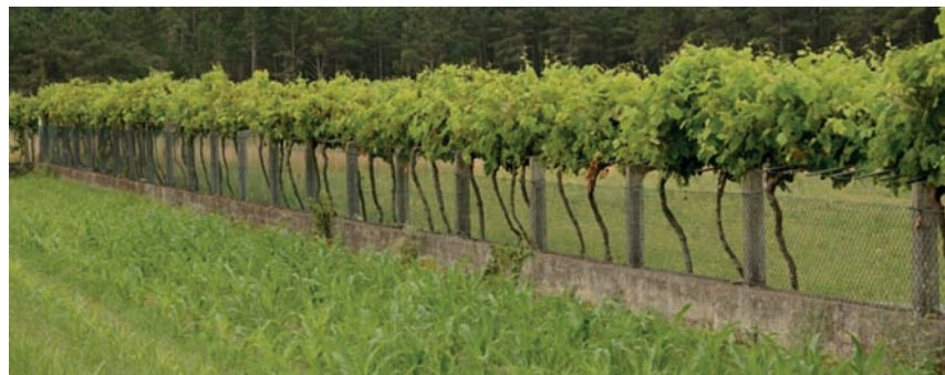
Imaxe 59: Valados de muros de formigón con postes de formigón e malla metálica de simple torsión
