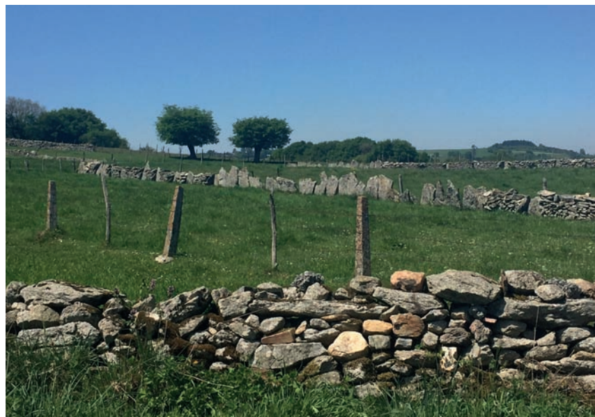
Imaxe 64: Valados tradicionais de cachotería e chantos de granito, así como mixtos con columnas de granito
