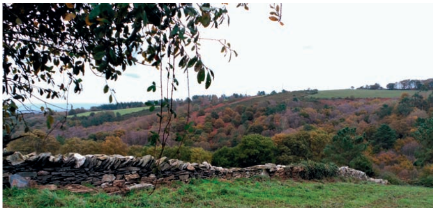
Imaxe c19: Valado de cachotería de xisto cunha última ringleira de pedras colocadas verticalmente
