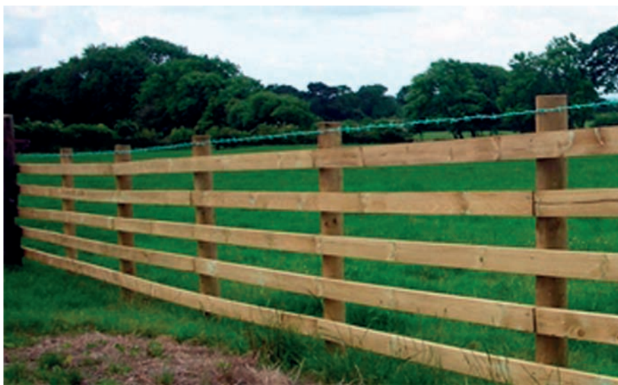
Imaxe 75: Exemplos de valados de madeira tratada
