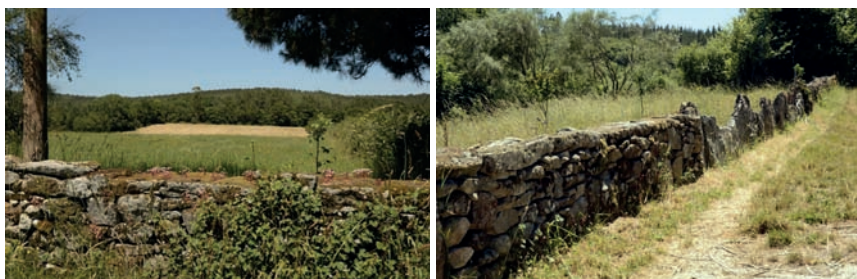
Imaxe c78: Valados de cachotería de granito e xisto
