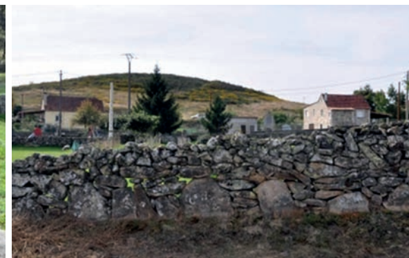
Imaxe c129: Valado de chantos de granito reforzado con cachotería
