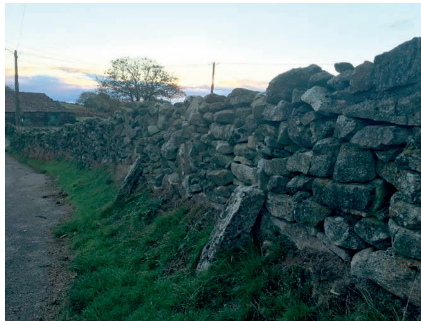
Imaxe c20: Valado de cachotería de xisto con contrafortes
