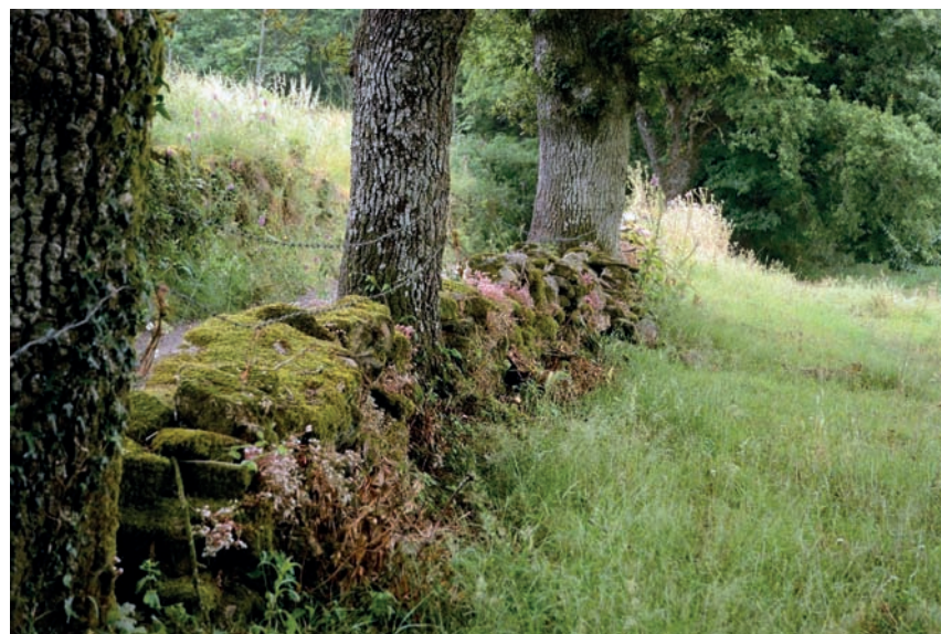
Imaxe c70: Valado de cachotería de xunta seca de granito con aliñación de carballos
