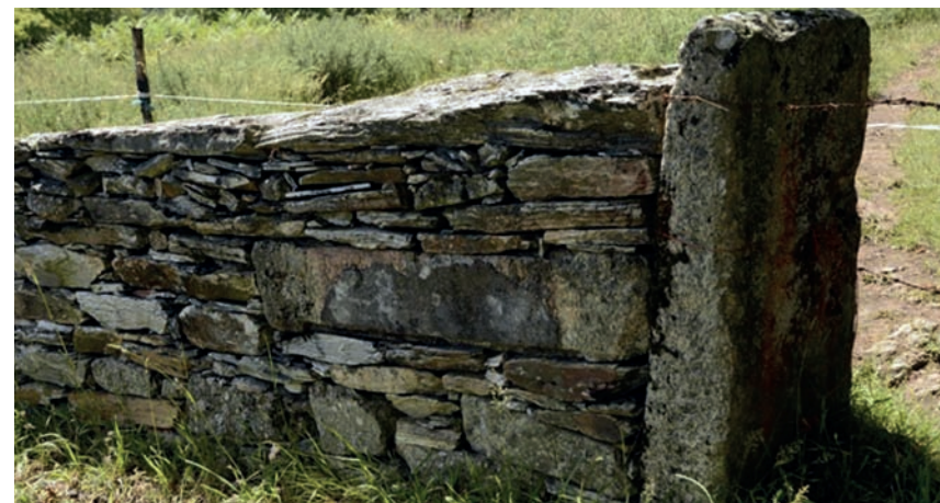
Imaxe c72: Exemplo de valado de cachotería de gran calidade con pedra labrada
