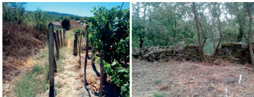
Imaxe c41: Valado de poste de madeira (marco para a vide) Imaxe c42: Valado de cachotería de granito
