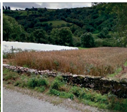
Imaxe c166: Valado baixo de cachotería de granito
