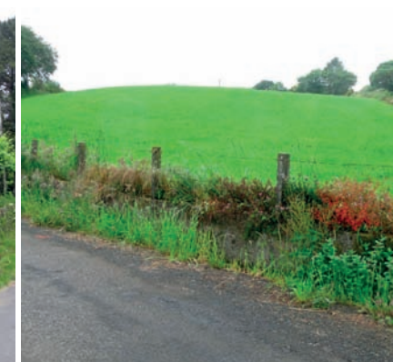
Imaxe c65: Valado mixto de formigón e arame
