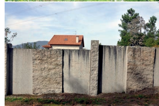
Imaxe 57: Arriba: Chantos de lousa con columnas e morteiro de cemento; centro e abaixo: Pastas de prancha de granito
