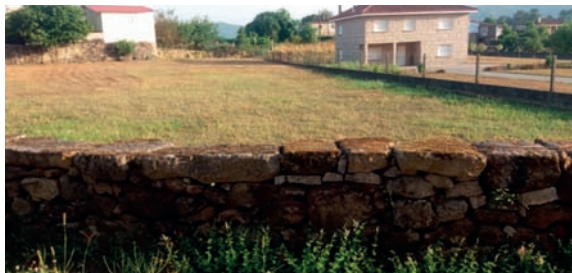
Imaxe c28: Valado de cachotería de granito no fronte das parcelas
