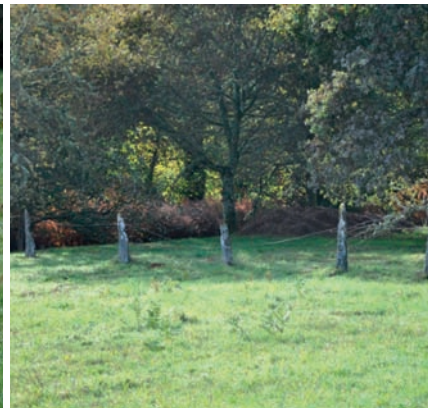
Imaxe c96: Límites con columnas de granito e arame
