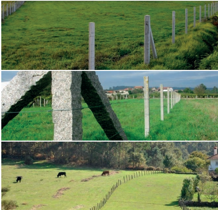
Imaxe 54: Valados mixtos. Arriba: Postes de formigón; Medio: Marcos con columnas de granito; Abaixo: Pastor eléctrico
