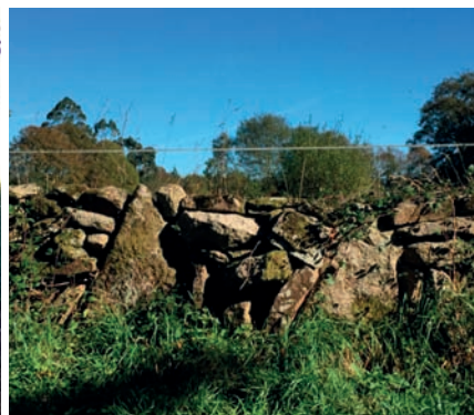
Imaxe c158: Valado de chantos de xisto con cachotería
