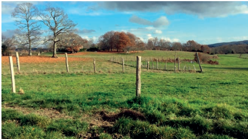
Imaxe c9: Valado mixto de estaca de madeira e arame
