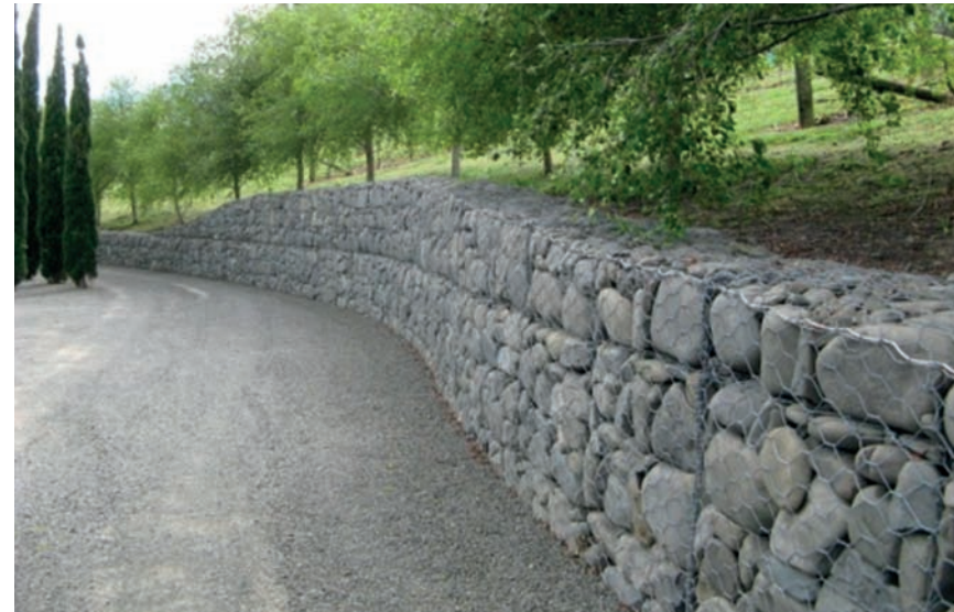
Imaxe 68: Gabiións empregados na construción dun socalco
