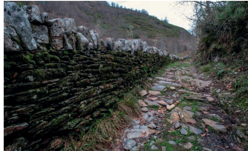
Imaxe 29: Valado de cachotería de xisto rematado cunha fileira vertical
