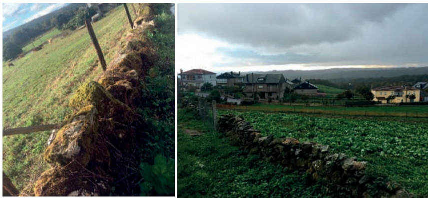
Imaxe c21: Reforzo de madeira e arame Imaxe c22: Valado de cachotería de xisto
