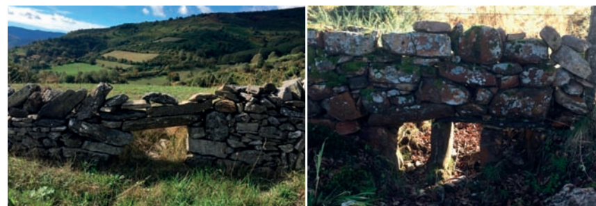
Imaxe 51: Vaos construídos para permitir o paso da auga. Autor: Hixinio Flores (primeira fotografía)
