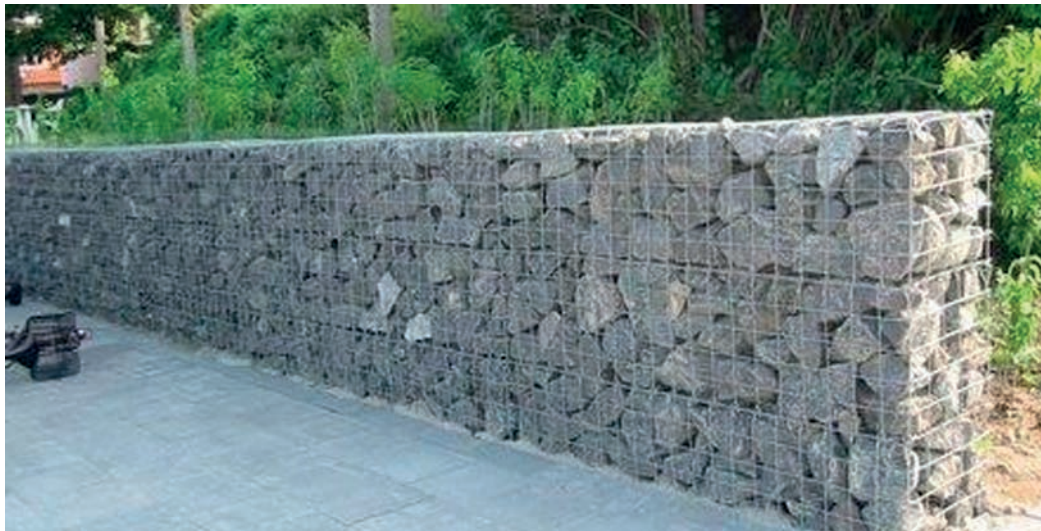
Imaxe 70: Exemplos de gabiións con distintos materiais
