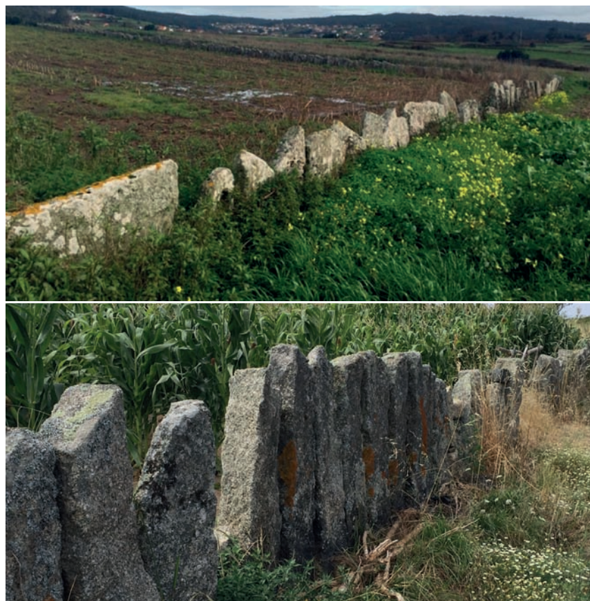
Imaxe 27: Valados de chantos de granito
