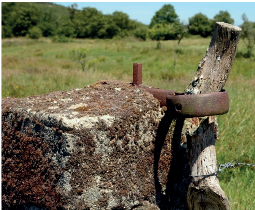
Imaxe 50: Exemplo de canzorro tradicional
