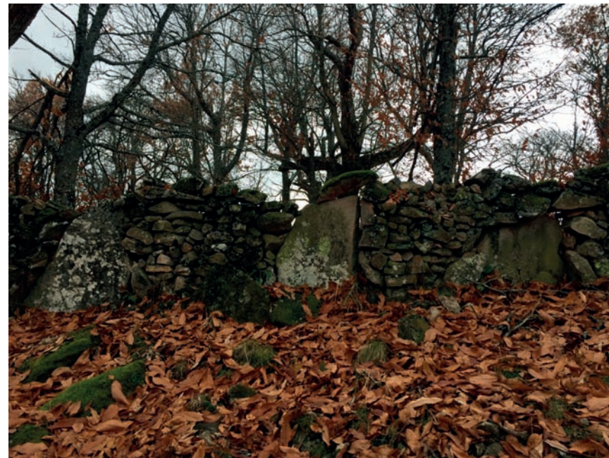
Imaxe c8: Valado de chantos de xisto reforzado con cachotería
