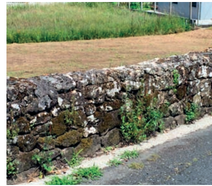
Imaxe c152: Valados de cachotería de granito (norte)
