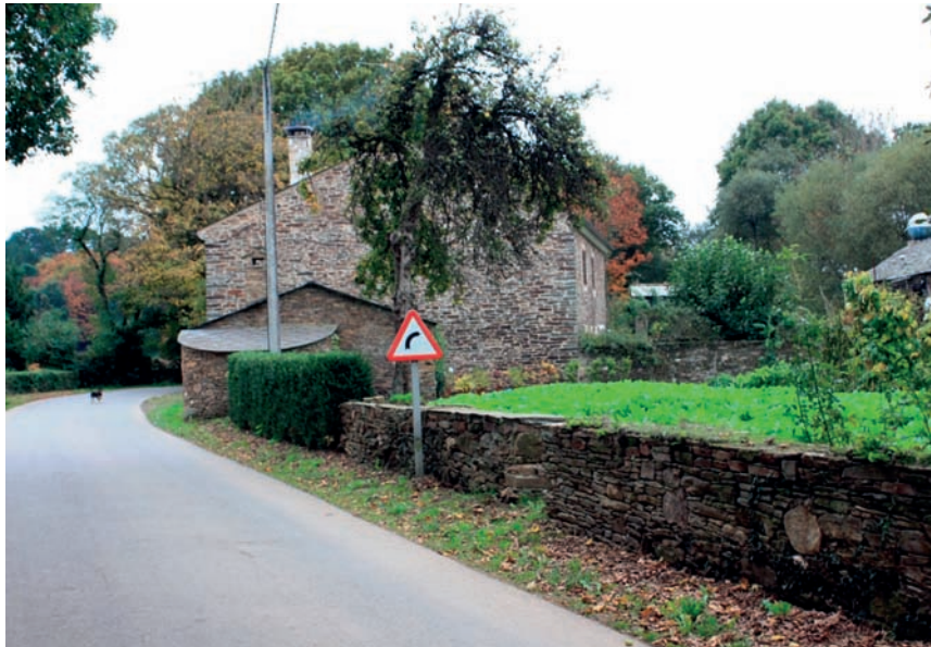
Imaxe 65: Muro de cachotería en solo de núcleo rural cunha altura inferior ós 1,5m
