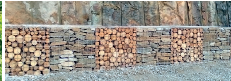
Imaxe 68: Gabiións empregados na construción dun socalco
