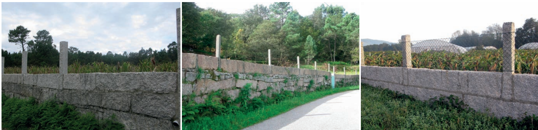
Imaxe 58: Arriba: Muro de perpiaño con columnas; Medio: Perpiaño irregular; Abaixo: Perpiaño con columnas e malla
