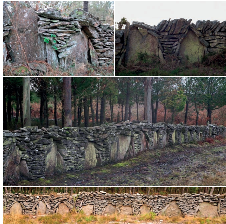
Imaxe 32: Valados de chantos reforzados con cachotería en seco. Autor: Hixinio Flores
