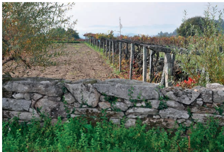
Imaxe c53: Valado de perpiaño (primeiro plano) e mixto con postes pétreos e viña (perímetro dereito)
