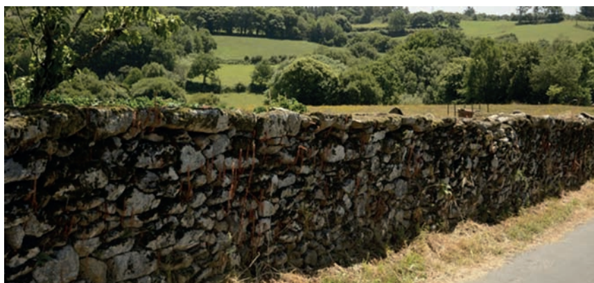
Imaxe c73: Exemplo de valado de cachotería de granito con muro alto (ate os 120cm)
