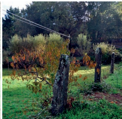
Imaxe c99: Límites con chantos a modo de postes
