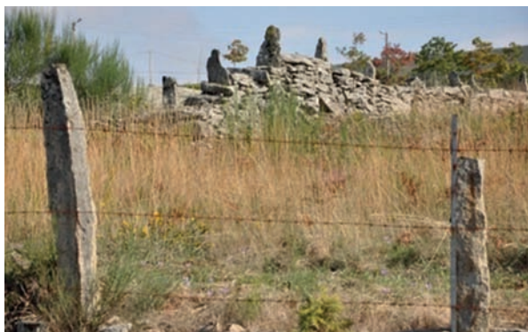
Imaxe c127: Valado mixto de postes de granito e arame
