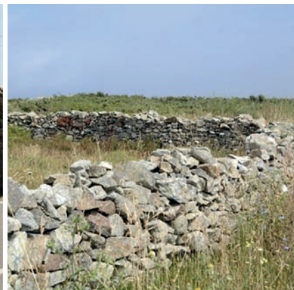
Imaxe c105: Muros de chantos verticais e cachotería pequena (chairas litorais, moi próximos ao mar)
