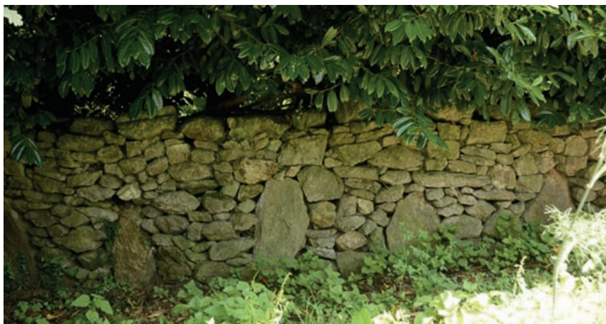
Imaxe c71: Valado de chantos de granito intercalados con cachote
