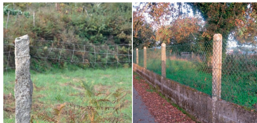
Imaxe 53: Valados mixtos con mallas. Esquerda: Malla gandeira con nós; Dereita: Malla de torsión simple con acabado verde
