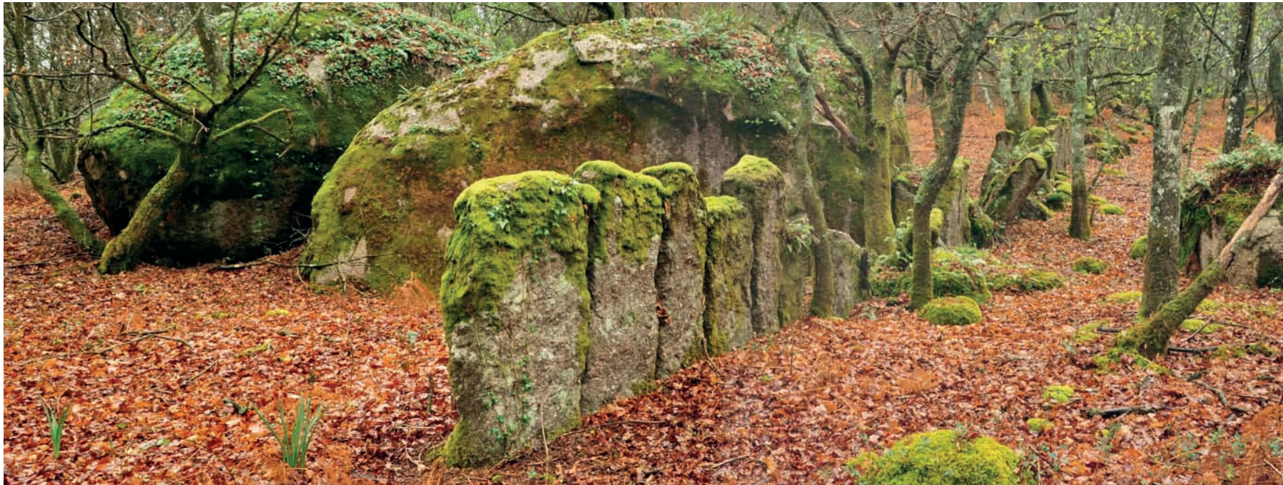
Imaxe 18: Exemplo de valado de chantos con xistos. Autor: Hixinio Flores
