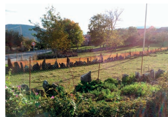
Imaxe c17: Valado de chantos de xisto con malla
