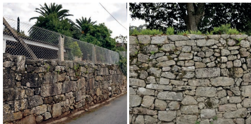
Imaxe c117: Valado de cachotería con columnas e malla Imaxe c118: Valado de cachotería de granito
