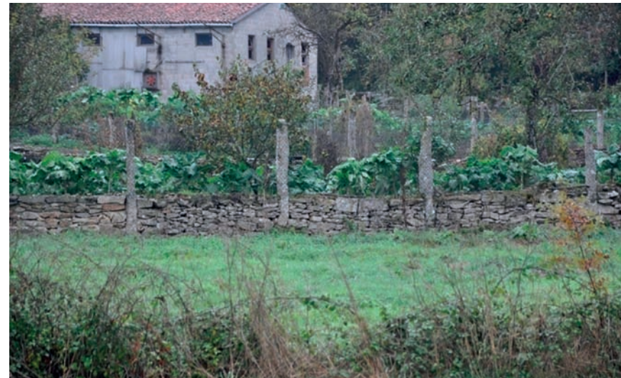
Imaxe 30: Valado de cachotería de xisto con columnas verticais
