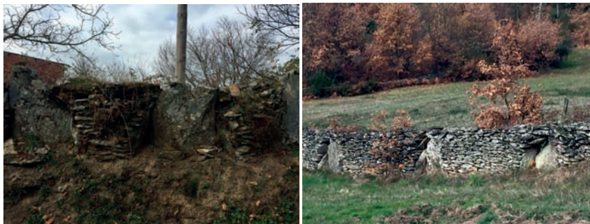
Imaxe c7: Valados de chanto de lousa con reforzo de cachotería
