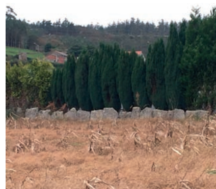
Imaxe c142: Valados de chantos irregulares de granito
